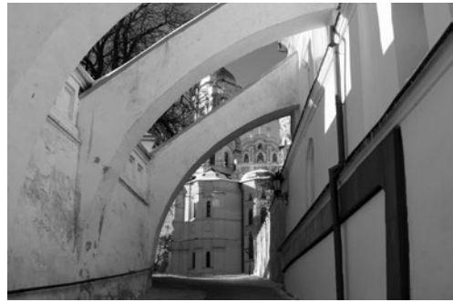
Рис. 12. Аркбутани друкарні в Києво-Печерській лаврі. Ілюстрація до енциклопедичної статті «Аркбутан». Фото В. Вечерського
